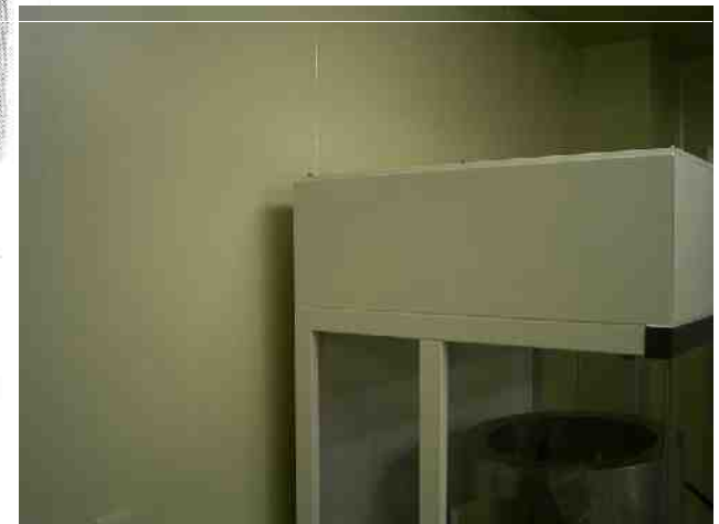
クリーンベンチの設置
